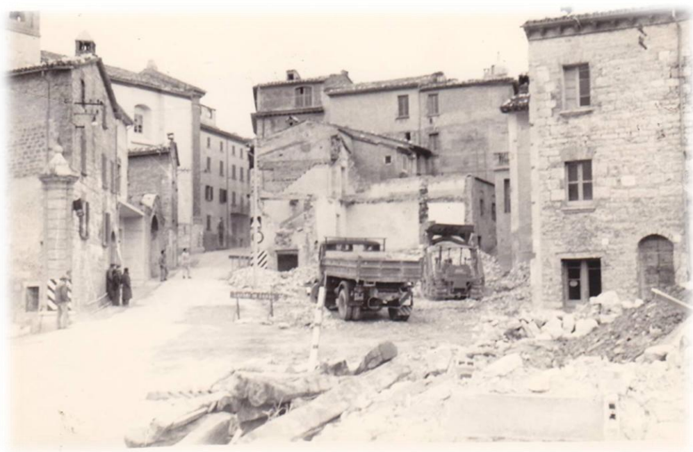
Lavori dello "Sventramento"
