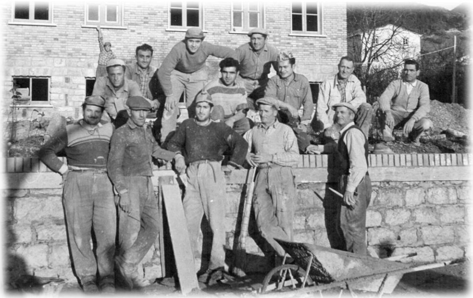
Sigillo - 1955 Operai sigillani nel cantiere della nuova scuola elementare. Palanga Guido, Parbuoni Giovanni, Bianconi Zefferino, Fiorucci Ennio, Moriconi Luciano, Menconi Nello, Andreoni Antonio, Mariani Ermanno, Scatoloni Corrado. Impresa costruttrice: Dormalfuoco Orfeo (Tuorosul Trasimeno)
