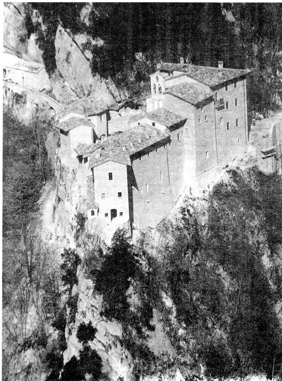
Ecco come si presenta oggi, dopo gli ultimi lavori di restauro, l'Eremo di Montecucco: una cittadella dello spirito, sospesa tra terra e cielo. (foto Luigi Pezzaldi)
