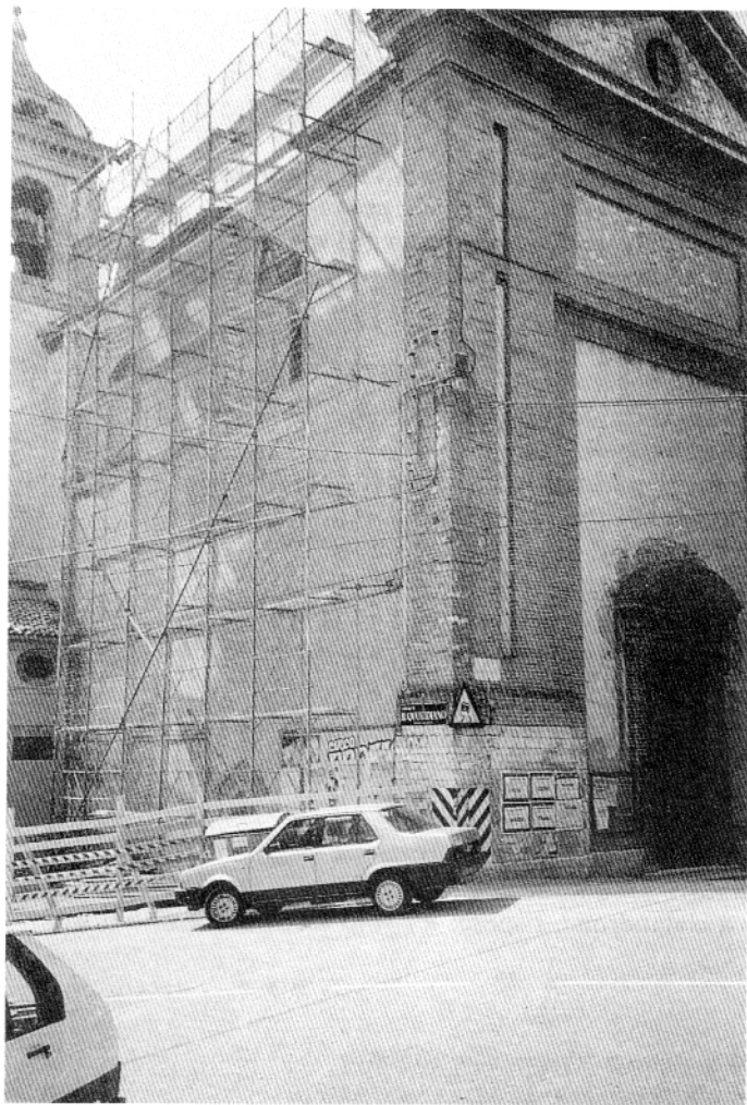
L'impalcatura della ditta Camesa cui è stato affidato il lavoro di restauro della chiesa e campanile di S. Agostino. (foto S.B.)
