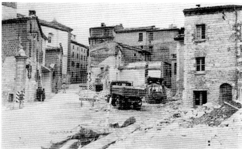
PRIME DEMOLIZIONI sulla salita di S. Agostino (1958)
